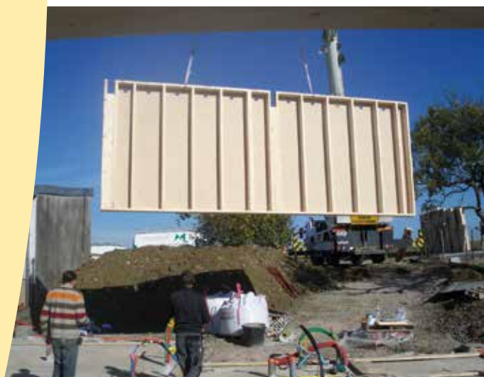
Pose de panneaux préfabriqués ossature bois
